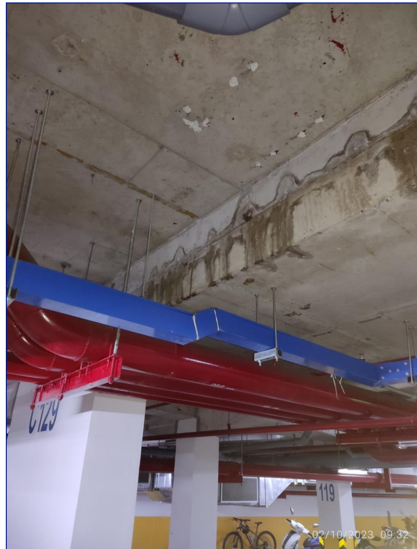
CÔNG TÁC SỬA CHỮA - KIỂM TRA THẨM KHU VỰC HẦM
