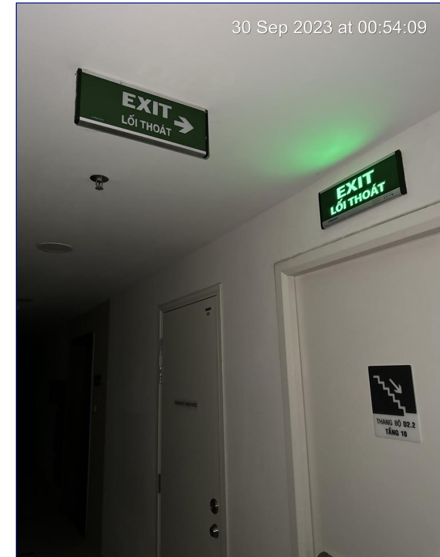
CÔNG TÁC ĐỊNH KỲ - KIỂM TRA ĐÈN EXIT
