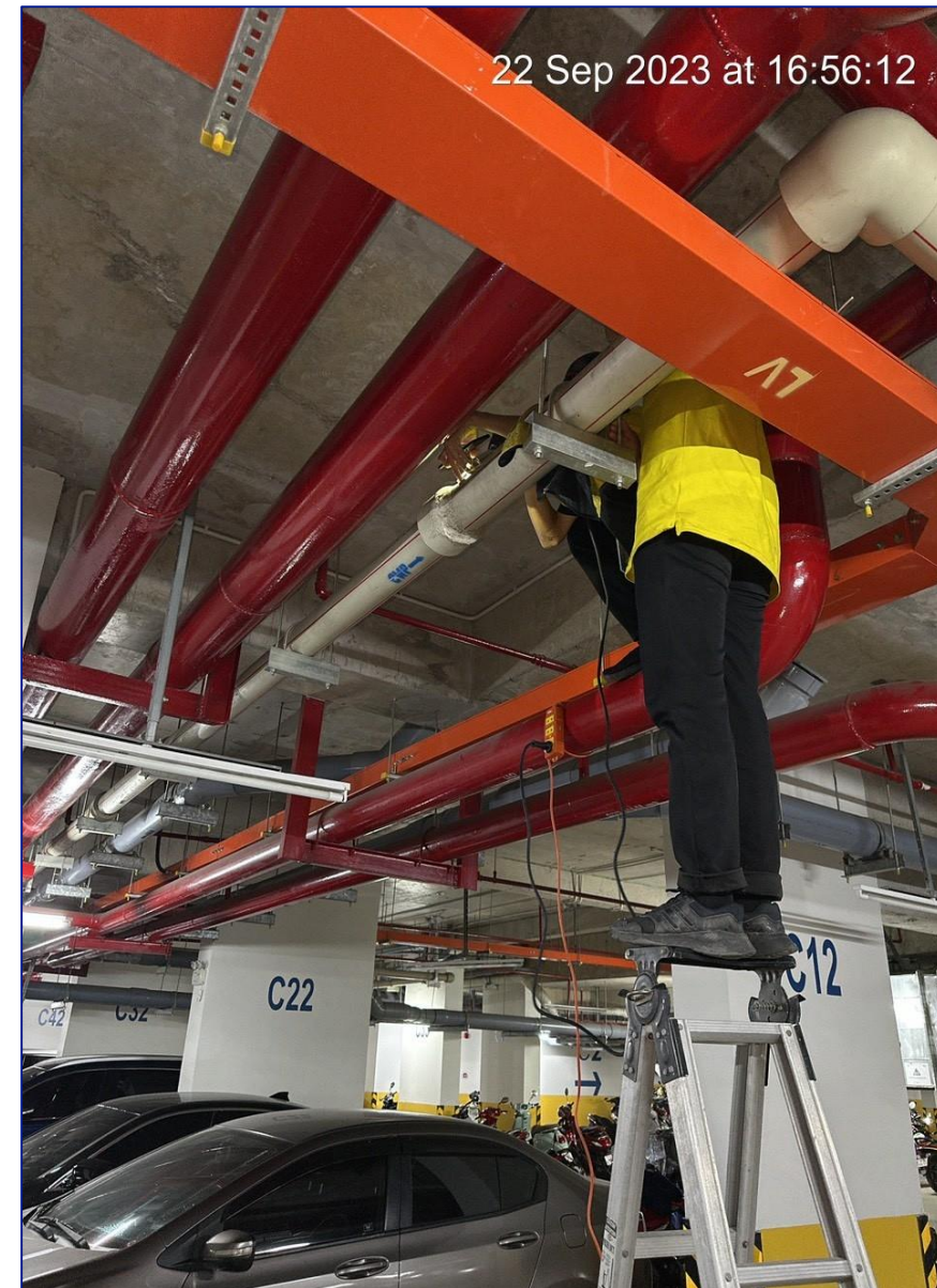
CÔNG TÁC SỬ CHỮA – SỬA CHỮA ĐƯỜNG ỐNG CẤP NƯỚC BỊ RỈ
