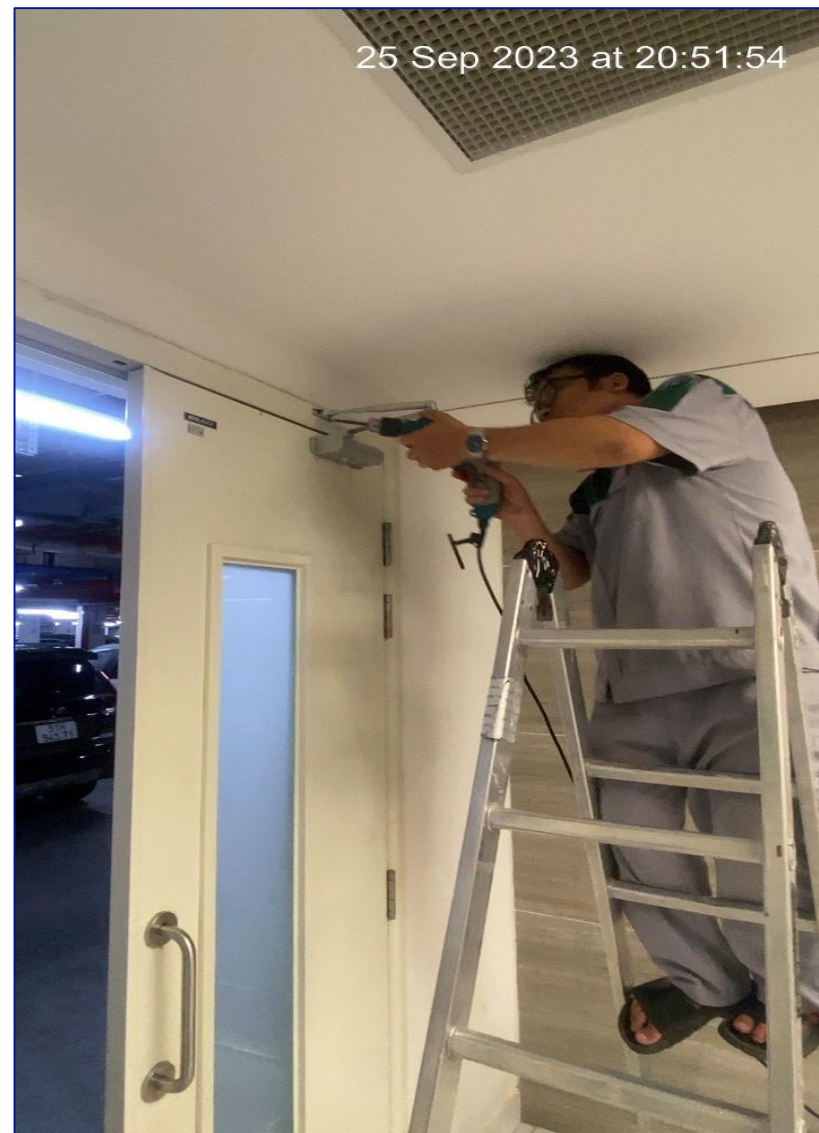
CÔNG TÁC SỬA CHỮA - TIẾN HÀNH THAY TRỞ HƠI SẢNH THANG MÁY
