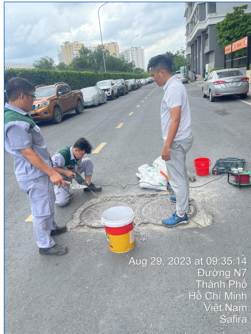
CÔNG TÁC SỬ CHỮA - NGÀY 29/08/2023 ĐƯỜNG NGOẠI VI
