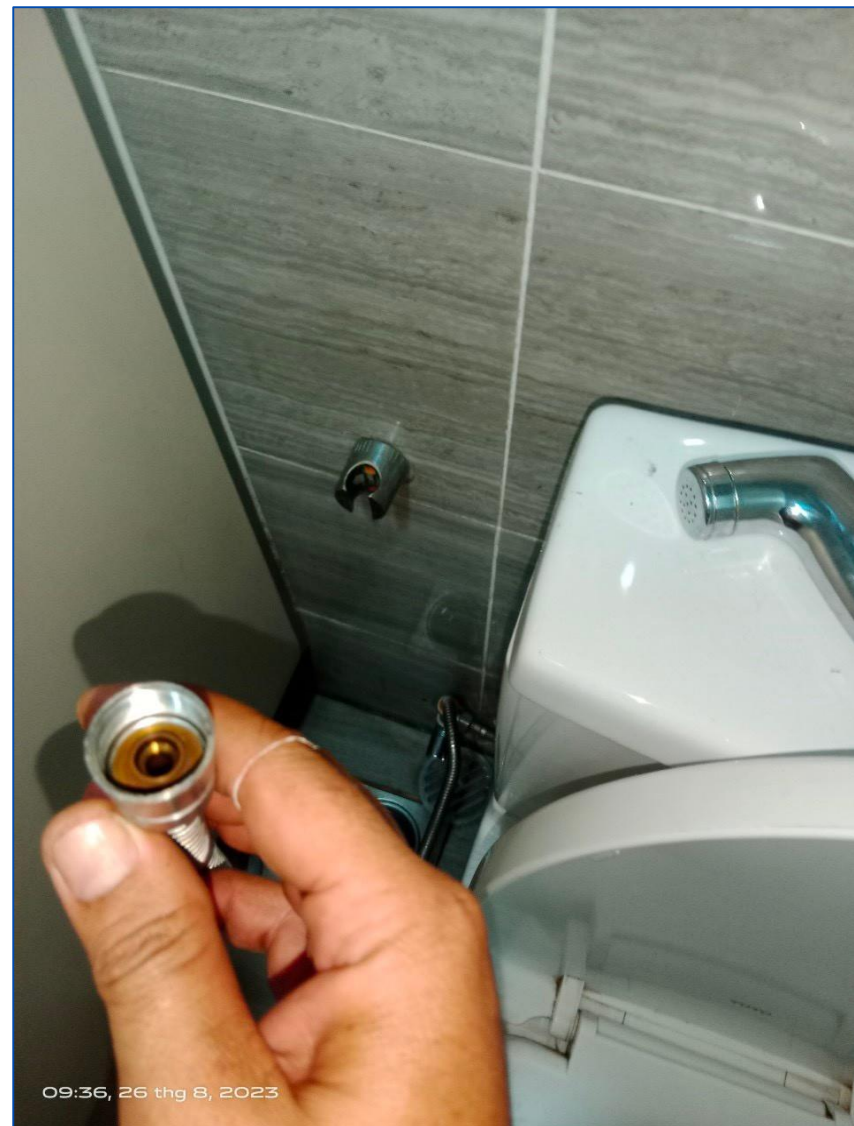
CÔNG TÁC SỬ CHỮA - NGÀY 26/08/2023 NHÀ VỆ SINH CÔNG CỘNG
