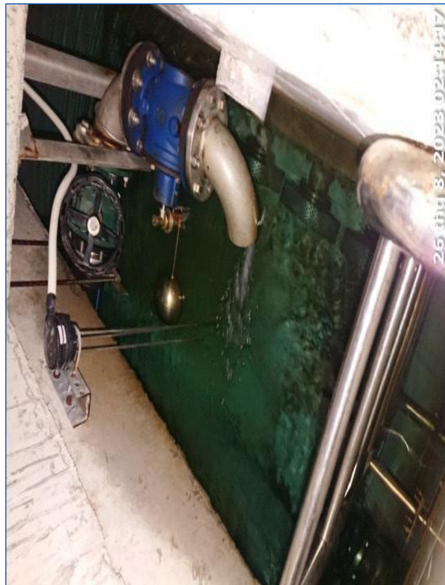
CÔNG TÁC ĐỊNH KỲ- NGÀY 26/08/2023 KIỂM TRA CẤP NƯỚC BỂ NGẦM
