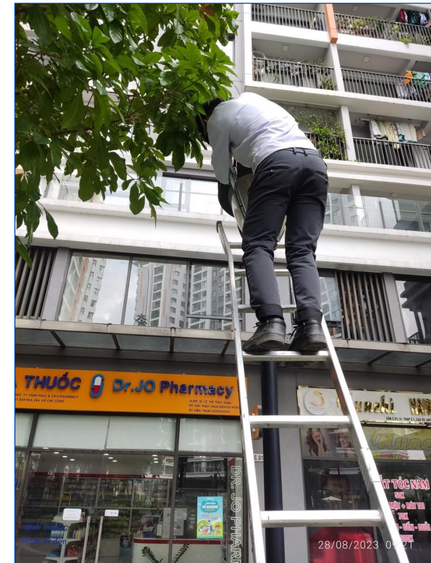
CÔNG TÁC SỬ CHỮA - NGÀY 29/08/2023 KIỂM TRA, SỬA CHỮA ĐÈN
