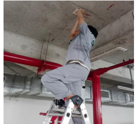
CÔNG TÁC ĐỊNH KỲ - 24/07/2023 BẢO TRÌ HỆ THỐNG PHÒNG CHÁY CHỮA CHÁY
