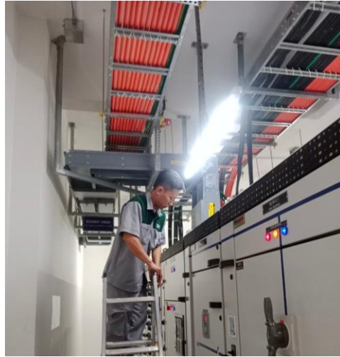
CÔNG TÁC ĐỊNH KỲ - 27/07/2023 KIỂM TRA, THAY MỚI ĐÈN PHÒNG ĐIỆN MSB
