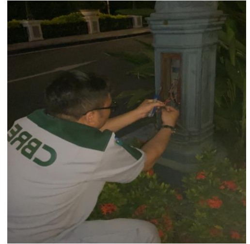
CÔNG TÁC SỬA CHỮA - 28/07/2023 HỆ THỐNG CHIẾU SÁNG NỘI KHU
