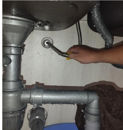
SỬA CHỮA NHỎ - 30/07/2023 CÔNG TÁC HỖ TRỢ CƯ DÂN
