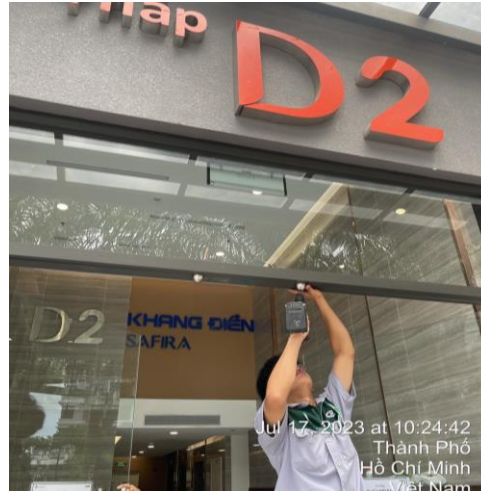
CÔNG TÁC SỬA CHỮA - 17/07/2023 LẮP ĐẶT CHẶN CỬA GIẢM THIỂU RỦI RO VỠ KÍNH
