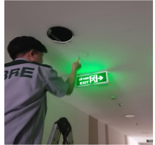
CÔNG TÁC ĐỊNH KỲ - 20/06/2023 THAY ĐÈN HÀNH LANG CÁC TẦP
