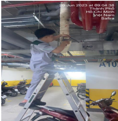
SỬA CHỮA NHỎ - 20/06/2023 SỬA CHỮA ĐƯỜNG ỐNG NƯỚC NGỪNG TRỤC BỊ RÒ RỈ
