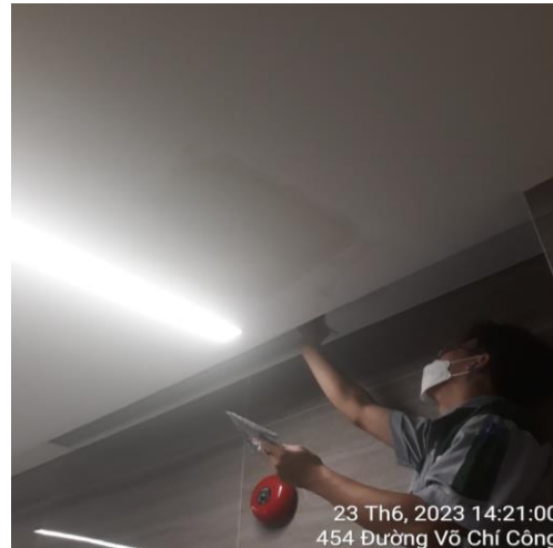
SỬA CHỮA NHỎ - 23/06/2023 VÁ TRẦN THẠCH CAO SẴNH BỊ HƯ HỎNG
