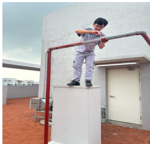
CÔNG TÁC KHẮC PHỤC- 17/06/2023 SƠN LẠI ĐƯỜNG ỐNG CHỮA CHÁY MÁI THÁP A
