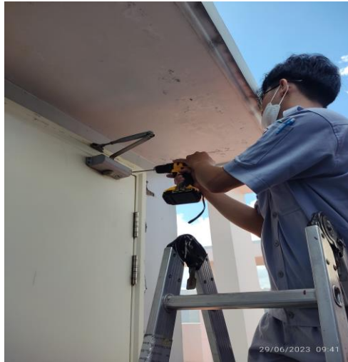
CÔNG TÁC ĐỊNH KỲ - 29/06/2023 KIỂM TRA, SỬA CHỮA TRỖ HƠI TẦNG MÁI 8 THÁP
