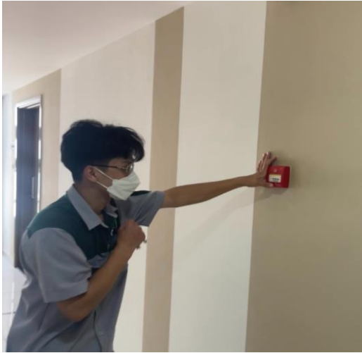
CÔNG TÁC ĐỊNH KỲ- 02/06/2023 KIỂM TRA LIÊN ĐỘNG HỆ THỐNG PCCC
