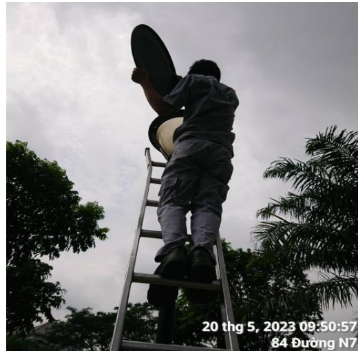
CÔNG TÁC ĐỊNH KỲ - 20/05/2023 KIỂM TRA, SỬA CHỮA ĐÈN NỘI KHU
