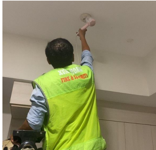
CÔNG TÁC ĐỊNH KỲ - 25/05/2023 BẢO TRÌ, BẢO DƯỠNG HỆ THỐNG PCCC
