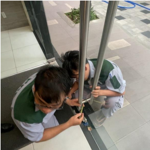
SỬA CHỮA NHỎ - 15/05/2023 KIỂM TRA CỬA SẢNH CÁC THÁP
