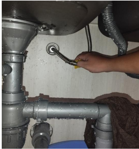
SỬA CHỮA NHỎ - 17/05/2023 CÔNG TÁC HỖ TRỢ CỬ DÂN
