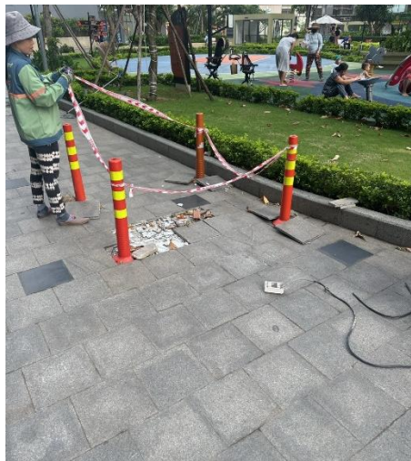
CÔNG TÁC KHÁC SỬA CHỮA ĐƯỜNG NỘI KHU
