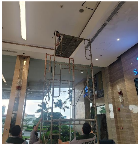
CÔNG TÁC KHẮC PHỤC - 30/04/2023 SỬA CHỮA MÁY LẠNH KHU VỰC SẢNH
