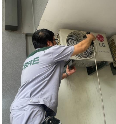
CÔNG TÁC ĐỊNH KỲ - 17/04/2023 VỆ SINH MÁY LẠNH KHU VỰC CÔNG CỘNG
