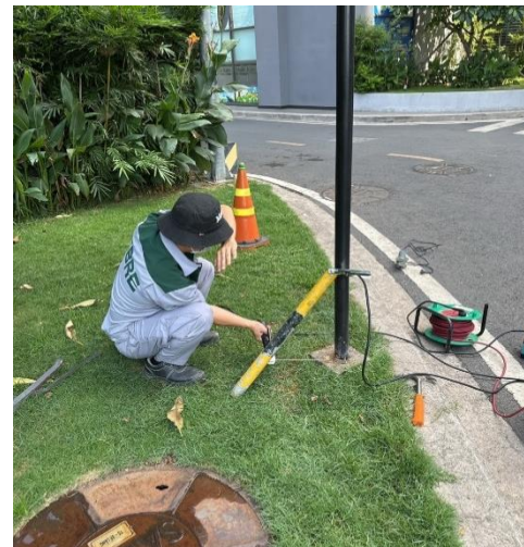
SỬA CHỮA NHỎ 29/04/2023 KIỂM TRA VÀ GIA CỐ CÁC BIỂU BÁO
